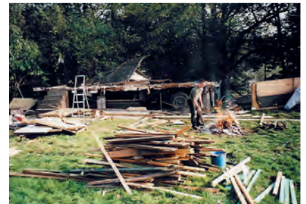
Der Rest des Bauwagens Im März kam der Graben für die Wasserleitung dazu.
