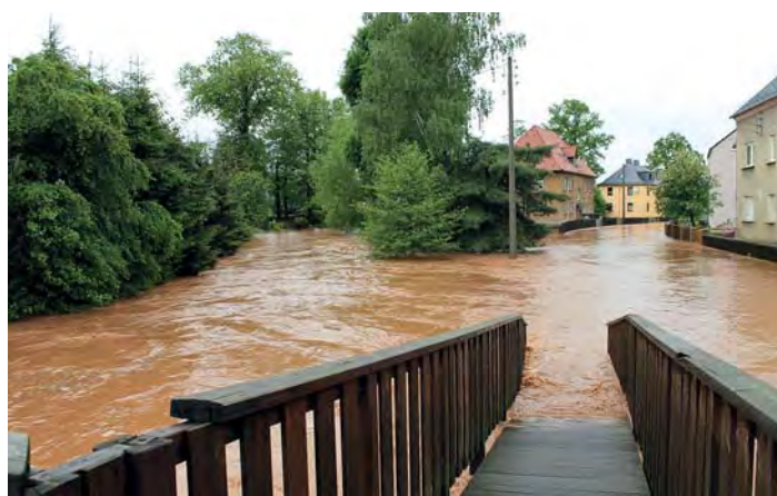
die heutige Reimannbrücke und Glauchauer Straße – bachabwärts
