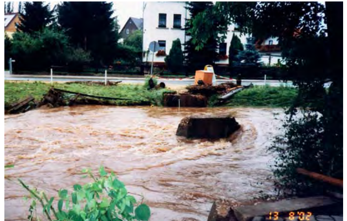
13.08.2002 Der Steg ist weggerissen. (Foto: Richter)
