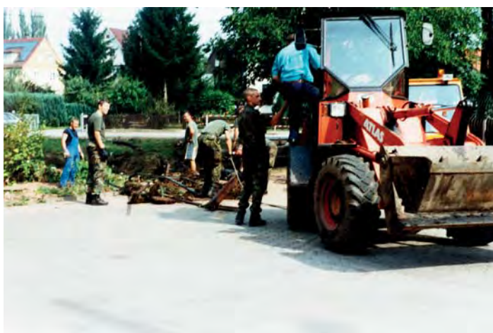
Bauhof und Bundeswehrosoldaten räumen gemeinsam auf.
