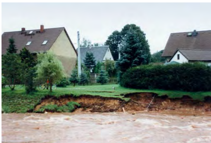
Verwüstungen rechts und links an der Kläranlage bachaufwärts
