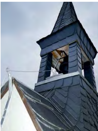
Bild 1 – Glocke der Friedhofskapelle in Kuhschnappel mit instandgesetzter Mechanik inkl. Seilzug
