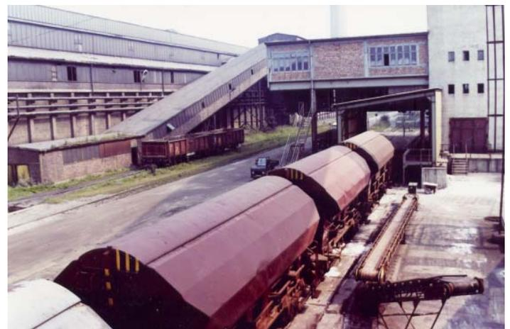
Bahnverladeeinrichtung (l. Erzlagerhalle und Bdbr. 01)
