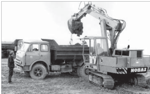
1. Spatenstich Callenberg Nord II mit Bagger 18.04.1977
