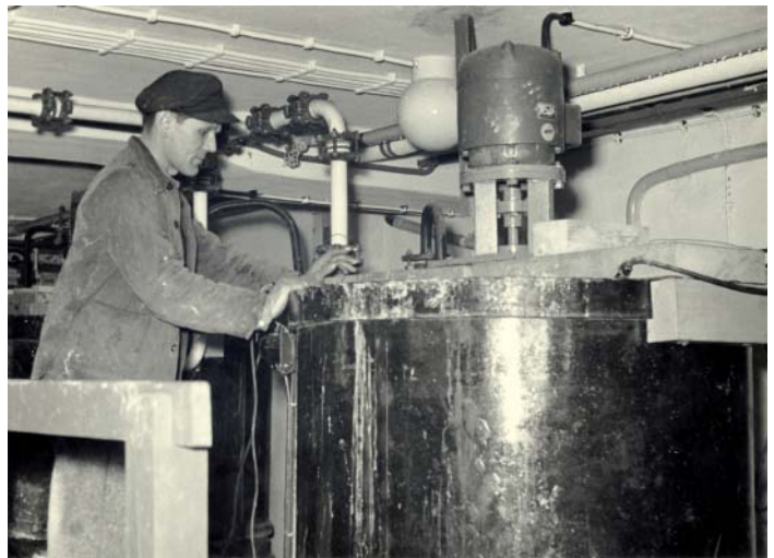
Reinstnickelversuchsanlage im Keller des Labors Erich Arzig am Rührwerk
