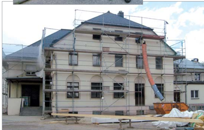
Sanierung und Modernisierung der Jahn-Turnhalle
