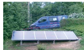
Solvis Referenzanlage, Schwaben, Hochleistungs-Flachkollektor Solvis Fera
