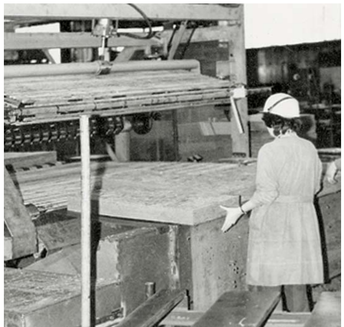
Mitarbeiterin der TKO bei der Probenahme von Mineralwolleplatten
