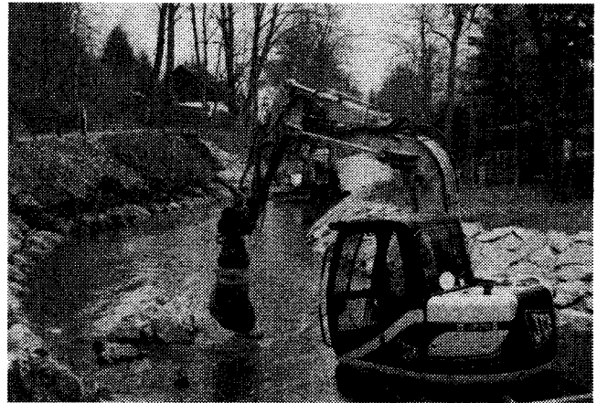
Die neue Böschung wird mit großen Bruchsteinen hauptsäch-lich durch die beiden Baggerführer erbaut. Hier 2 Aufnahmen vom 3. April 2007. Foto: G. Keller
