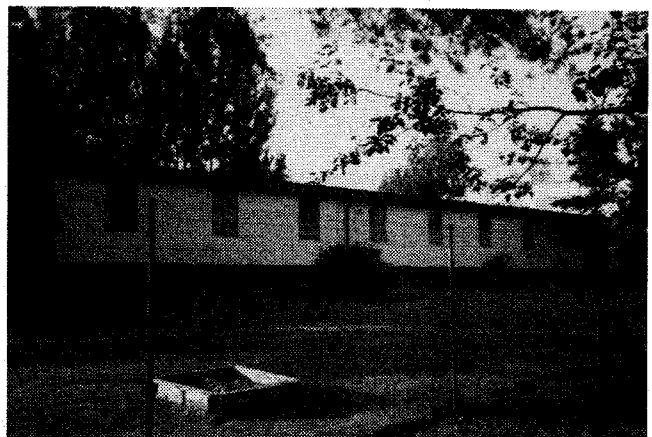
Nach Sanierung von ORIS, Oktober 1994.
