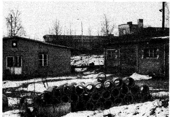
Verwaltungsbaracke mit Garage, um 1970.
