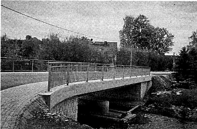
Im Rahmen der Hochwasserschadensbeseitigung erfolgte der Ersatzneubau der Brücke an der Schillerstraße.
