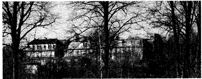
Die Gebäude der ehemaligen Strickwarenfabrik Albert Rabe im April 2003 sind gegenwärtig dem Verfall preisgegeben.
