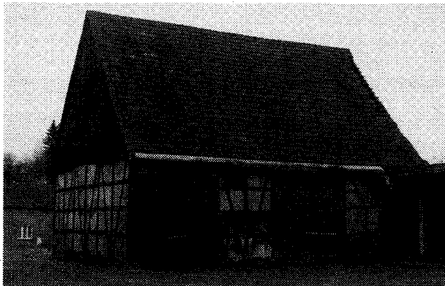
Scheune mit 2 großen Schiebetoren.
