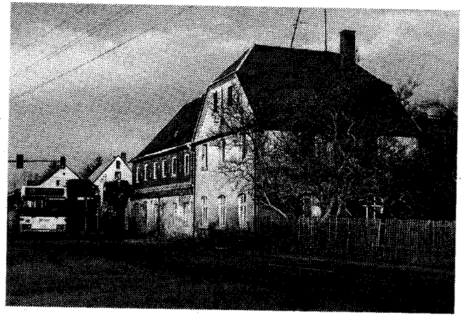
Abriss wegen Baufälligkeit im Januar 2005.
