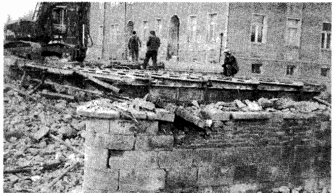
Die Reste der "Großen Brücke".
