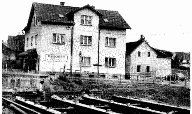
Die Stahlträger-Konstruktion selbst hätte noch einige Jahre standgehalten.
