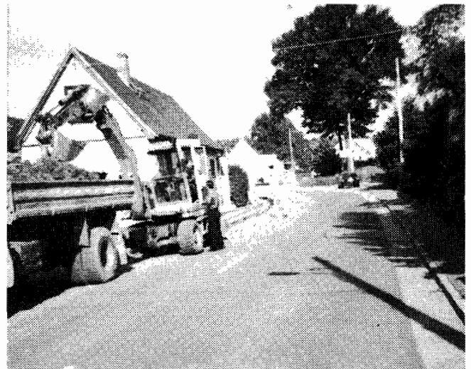
Dieses Bauvorhaben wird von der Firma Tief- und Rohrleitungsbau Schulz GmbH & Co., Leukersdorf durchgeführt. Der Straßenverkehr wird während der Bauzeit durch Ampelregelung gesichert.
