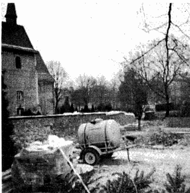
Im Rahmen einer AB-Maßnahme wird die Friedhofsmauer in St. Egidien wieder neu aufgebaut. Die Bürger unseres Ortes und die Besucher des Friedhofes freut es sehr.
