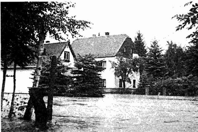
Zwischen den Häusern soll eine Straße verlaufen??? Kaum zu glauben! Gebäude an der Lungwitzer Straße 64 und 65.
