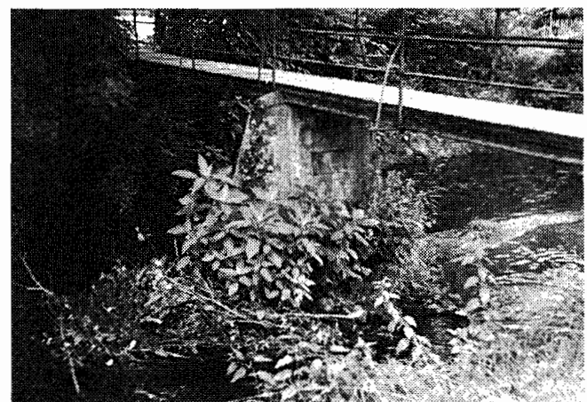
Mit einem tollen Bewuchs am 22. Juni 2002 ...
