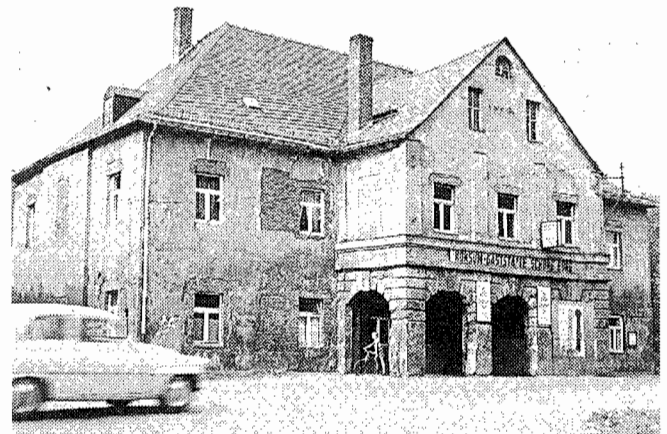
Ansicht des Gasthofes Aug. 1965 kurz vor Abbruch des Vorbaues.
