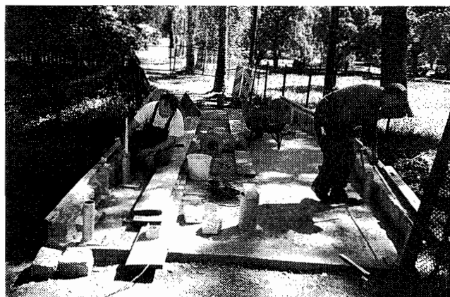
Mitarbeiter der Firma Reinhold beim Einsetzen der Geländehülsen.
