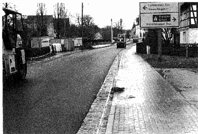
1. Abschnitt der Deckensanierung Lungwitzer Straße bis Einmündung Gewerbegebiet "Am Auersberg".
