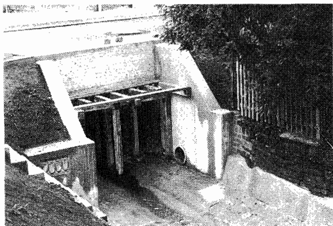
Erneuerung des Brückendurchlasses Kuhschnappelbach in Nähe Lungwitzer Str. 80.
