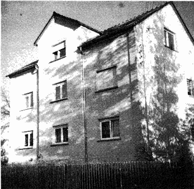
Erneuerung Außenfassade Lungwitzer Str. 47.
