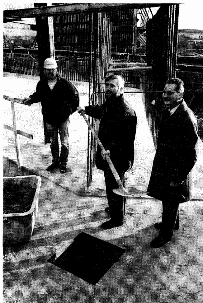
Die Bürgermeister Sedner und Keller bei der Grundsteinlegung.
