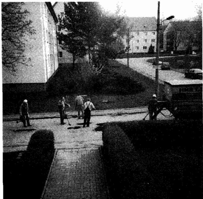
Ausbesserungsarbeiten auf der Schulstraße. Text und Foto: Horst Tauber
