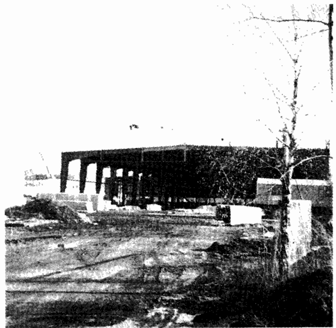
Die Firma Oris feierte am 11. 11. 1999 Richtfest für den Bau ihrer neuen Produktionshalle. Nach Fertigstellung wird sie für den Teilbereich Verpackung, Lagerung und Verkauf ihre Funktion aufnehmen.
