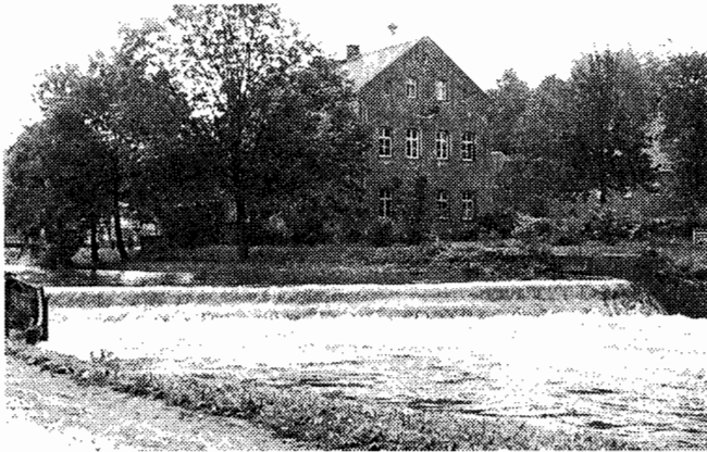
Das Wehr nach der Erneuerung im September 1961.
