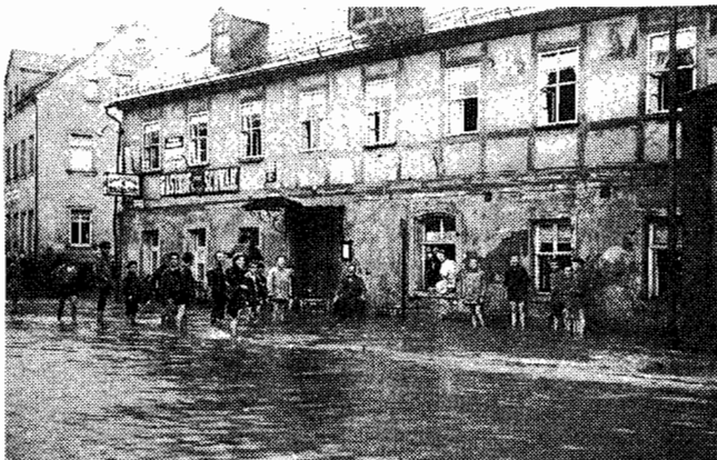
Hochwasser am ehemaligen Gasthof "Zum Schwan".
