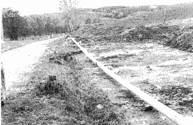
Verlegung der Hochdruckgasleitung an der Lobsdorfer Straße zur "Neuen Palla".
