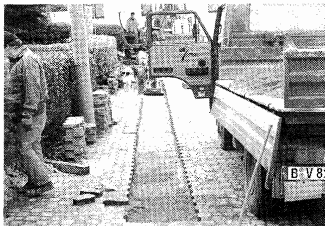
Netzumstellung der EVS auf 220/380 V im Ortskern, Verlegung der Leitungen in der Erde.
