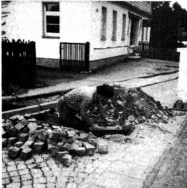
Die Lungwitzer Straße wird mittels Luftdruck durchbohrt.
