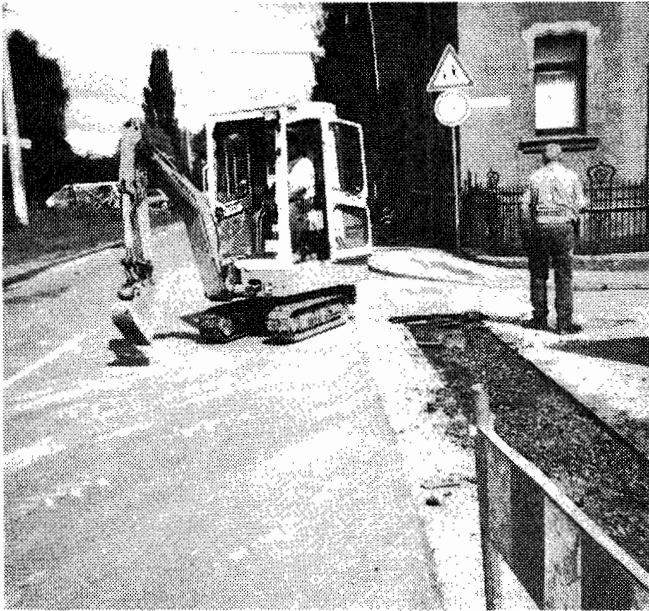
Vorbereitung zum Verlegen des Kabels.
