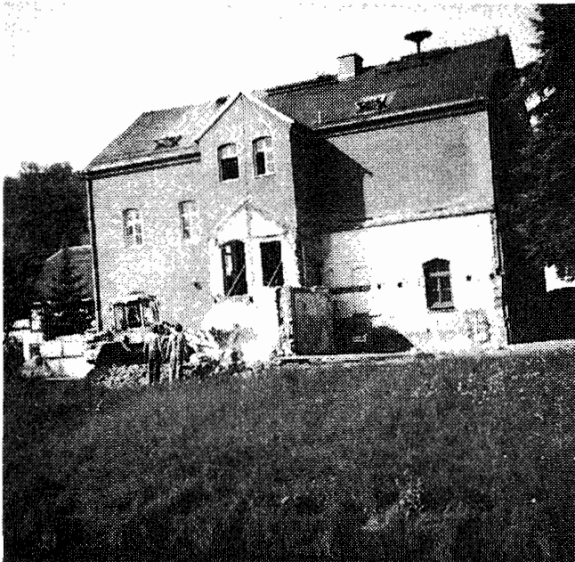
Abrißarbeiten am Rathaus.
