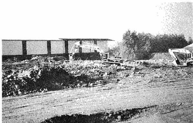
Restliche Fundamente von der Drehrohrofenanlage (Schaltgruppe 02).
