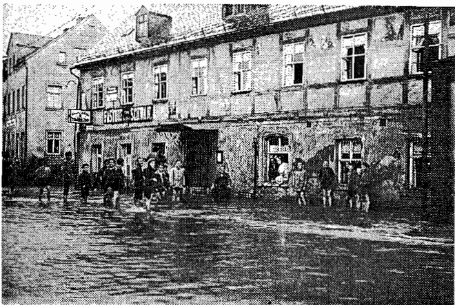
Historische Aufnahme vom Gasthof "Zum Schwan" während des Hochwassers im Jahre 1924.
