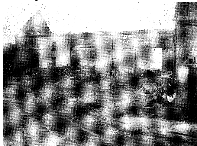
Die Scheune vom Gerth-Turm brannte am 18. 2. 1930 völlig aus.
