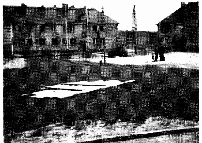
Die ersten Wohnblocks im Jahre 1954, im Hintergrund der Aufbau der Nickelhüttenesse.
