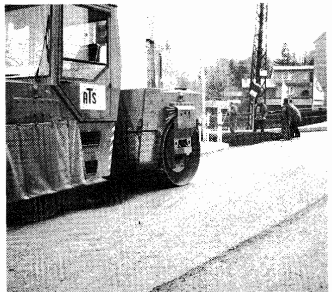
Die Mitarbeiter ATS Chemnitz bei den Bauarbeiten auf der Bahnhofstraße.
