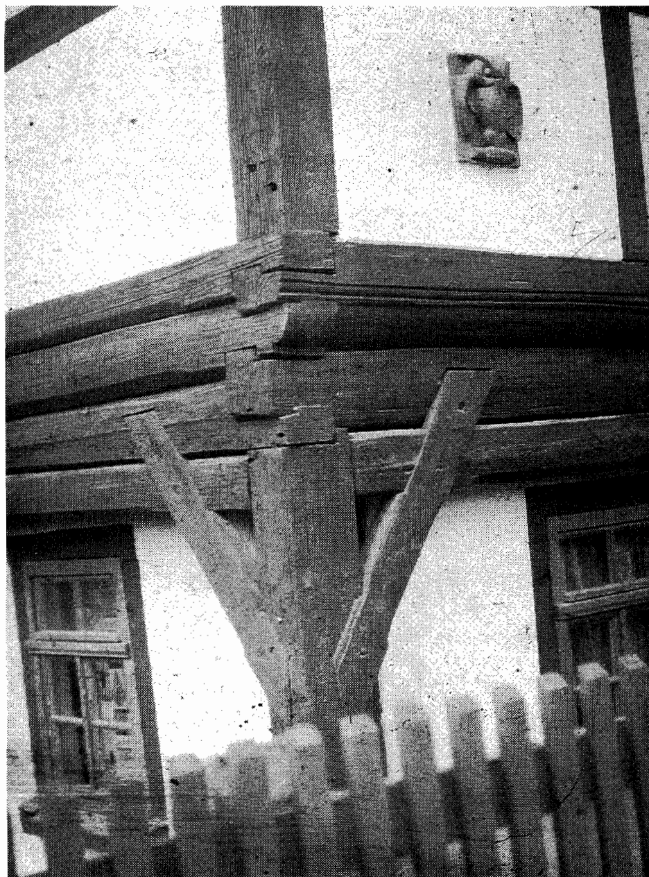
Das Umgebinde des Eulenhauses um das Jahr 1985 an der Glauchauer Straße 32 Foto: G. Keller
