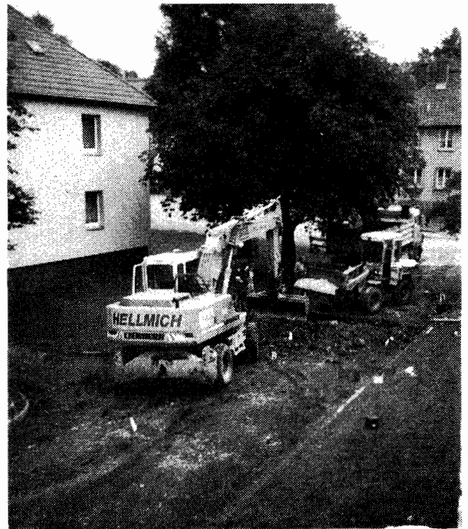
Beginn der Arbeiten mit der Technik.
