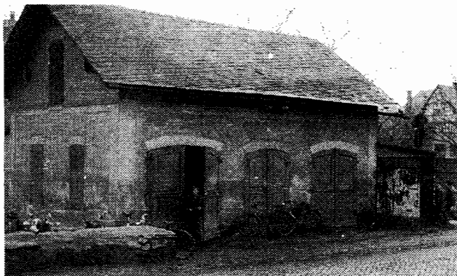
Das Feuerwehrgerätehaus vor dem Umbau 1963.
