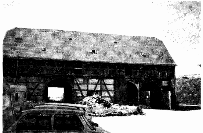
Die unter Denkmalschutz stehende Scheune mit Laubengang vom Ackermann-Gut im Jahre 1992
