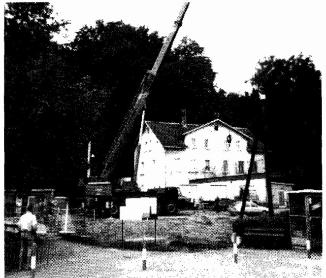
Präzisionsarbeit: Mit einem 70-t-Mobilkran wird das Brückenteil auf die vorhandenen Lager aufgesetzt.
