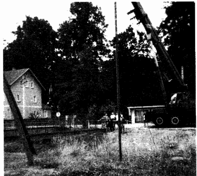
Die 4,5 t schwere Brücke ist an ihrem Bestimmungsort, und es kann der Belag aufgebracht werden.
