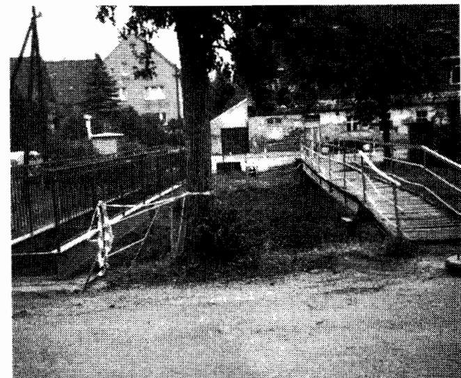
Noch sind es zwei Brücken: Die neue konnte rechtzeitig zum Schulbeginn fertiggestellt werden. Die alte Brücke wird demnächst beseitigt.
