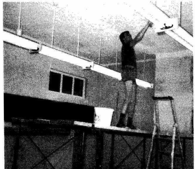
Fleißige Helfer sind dabei, die Klassenzimmer neu zu streichen
