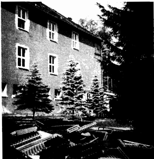
Demontage der alten Heizung - Gußradiatoren warten auf ihren Abtransport
