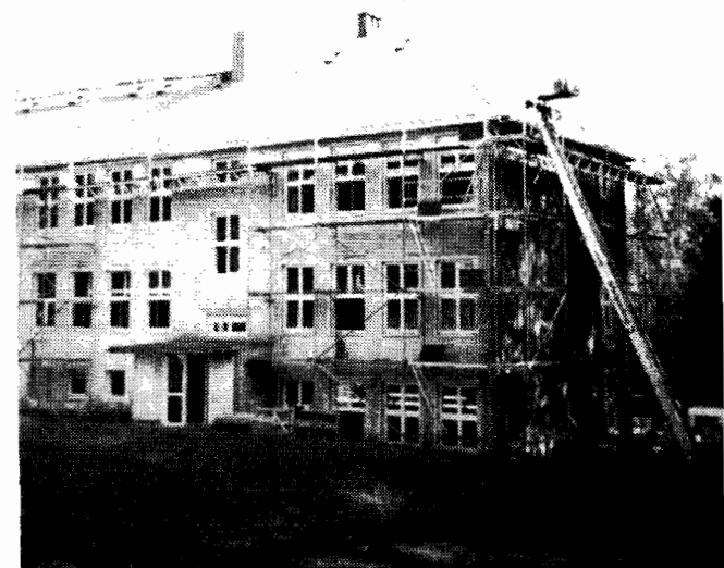
Auch an sehr heißen Tagen wurde das Dach neu eingedeckt
