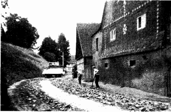
Entfernung des Pflasters auf der Glauchauer Straße
