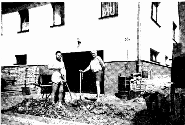
Herr Kahl und Herr Scheibner bei Vorbereitungsarbeiten zum Pflastern
