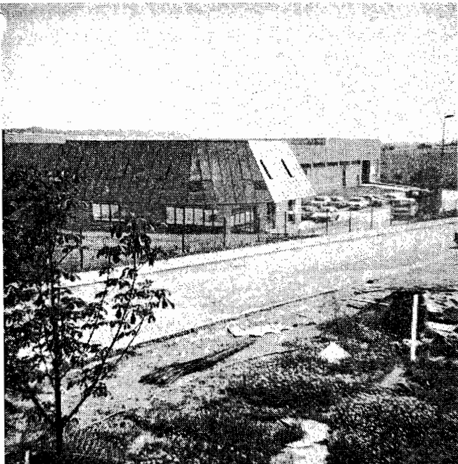
Ein Blick auf die Firma Glaswerke Arnold im Gewerbegebiet "Am Auersberg"
