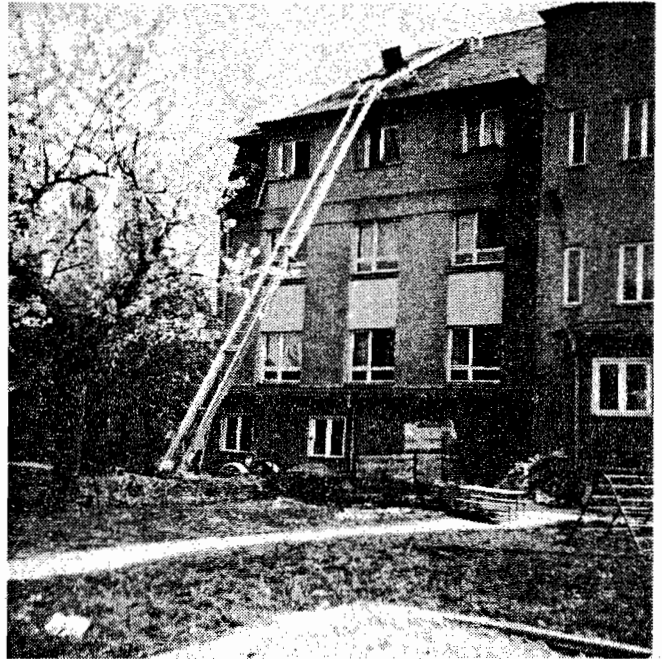
Die Arbeiten zur Heizungsumstellung auf Gas sind in der Kinderkrippe in vollem Gange. Der Feuerungs- und Schornsteinbau Gersdorf, Firma Talkenberger und Weber mauern im Kinderkrippengebäude einen neuen Schornstein hoch.
