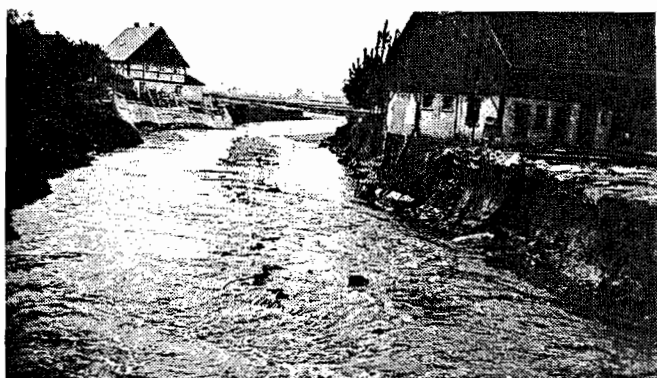
Nach dem Hochwasser
