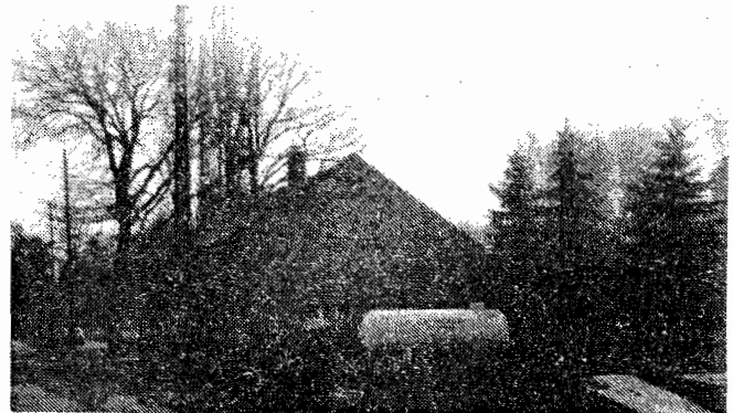
Von der Feuerwehrabgabe der Bürger für das Jahr 1991 erfolgte u. a. die Heizungsumstellung des Feuerwehrgebäudes.
